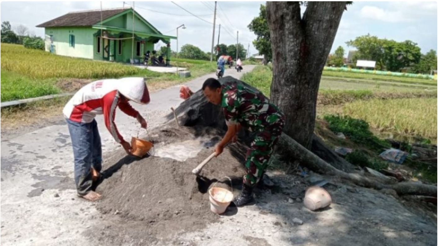
Wujudkan Kemanunggalan TNI dan Rakyat, Babinsa Wonosari Bantu Buat Talud Jalan
