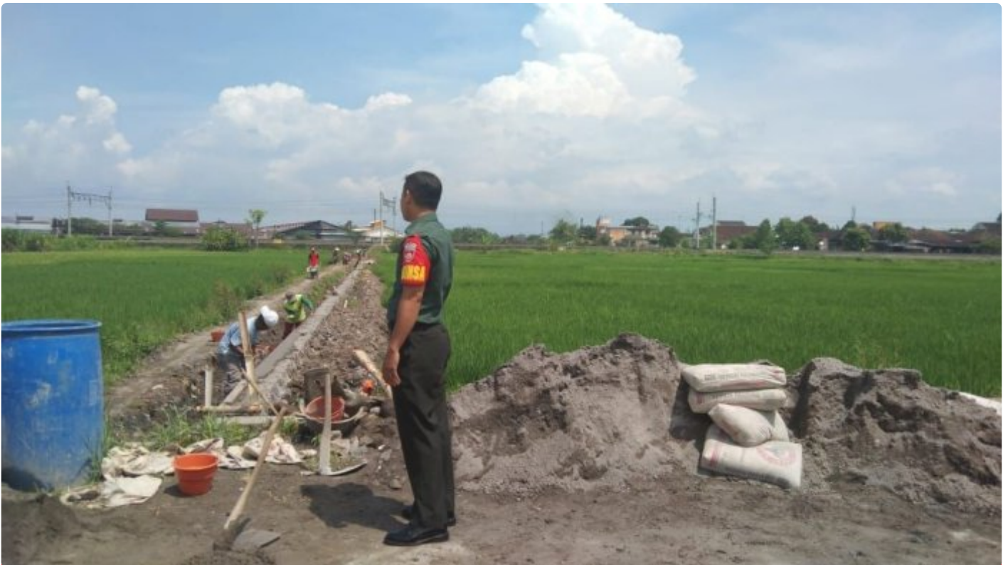
Pengerjaan Saluran Irigasi, Babinsa Ceper Lakukan Monitoring
