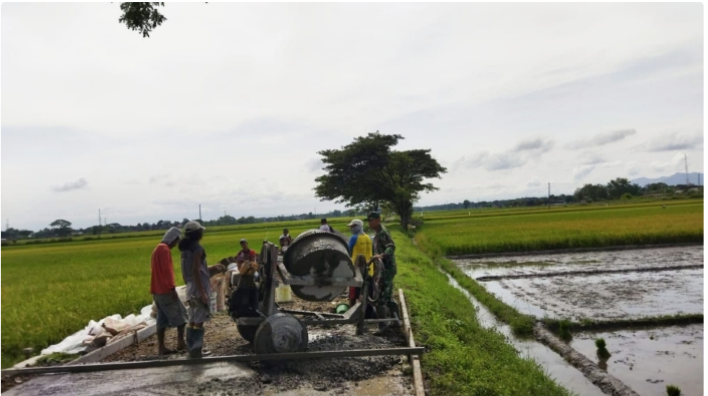
Gotong Royongnya Babinsa Juwiring Bantu Betonisasi Jalan
