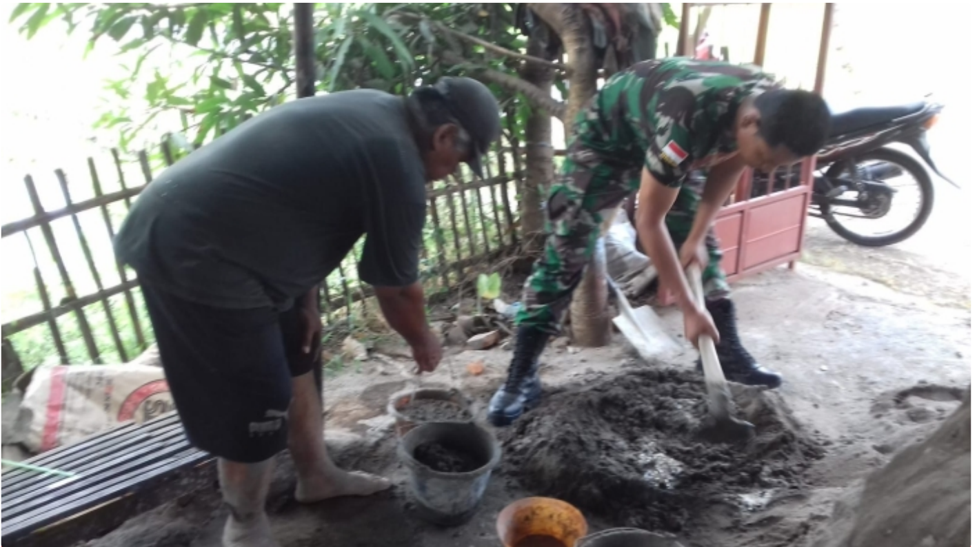
Babinsa Ceper Bantu Warga Renovasi Rumah Binaannya
